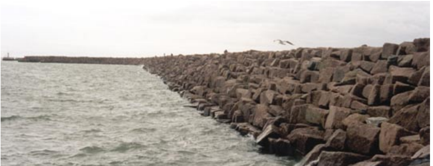
Kuva 10. Luonnonkivilouhimon sivukivi soveltuu erityisen hyvin vesirakentamiseen. Kuva: Palin Granit Oy.
